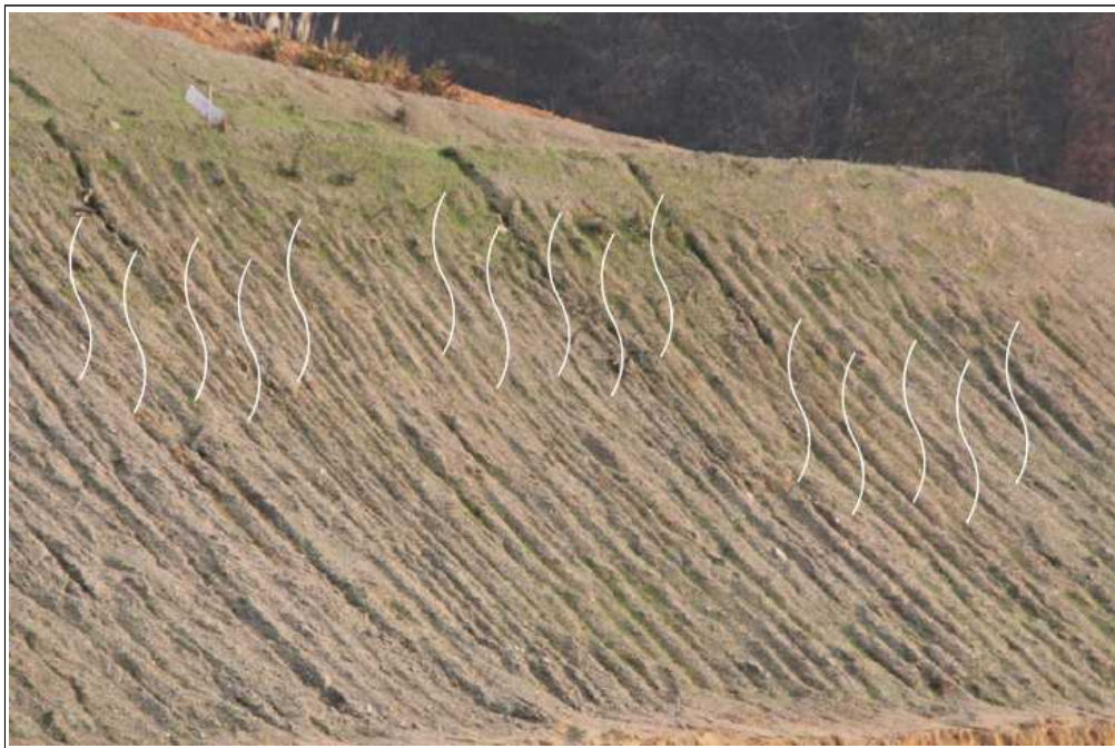
【그림 29】 C 영역 상세사진 (토사유실 및 우류침식)
