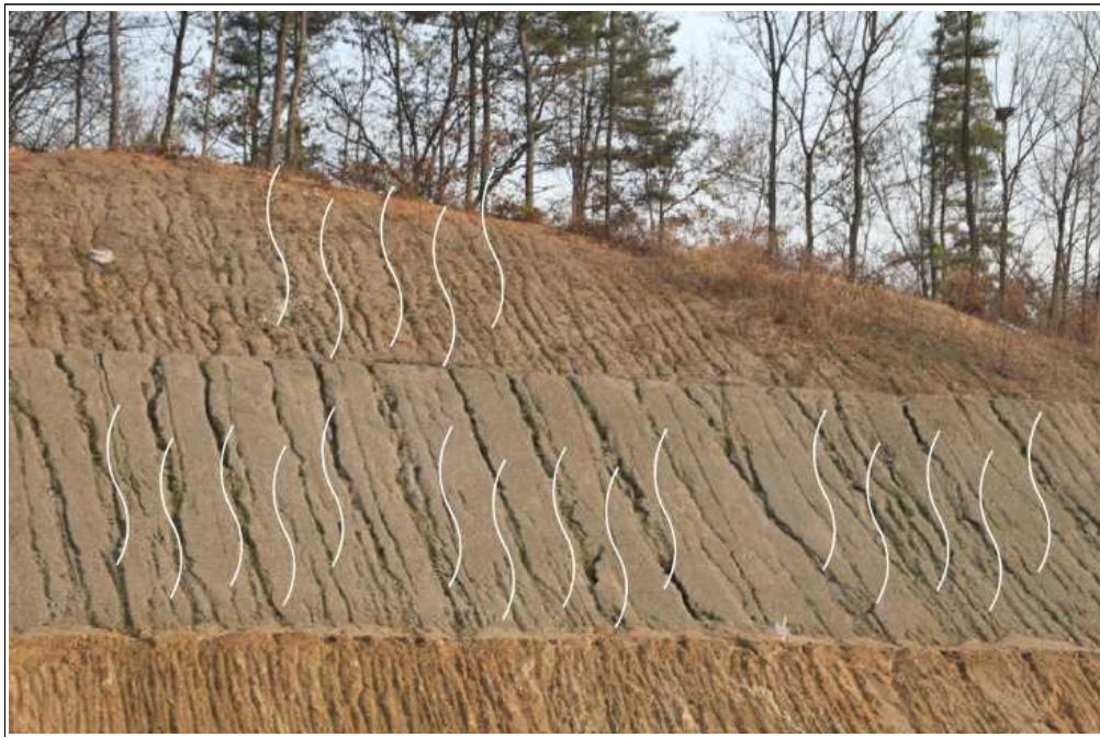
【그림 27】 C 영역 상세사진 (토사유실 및 우류침식)
