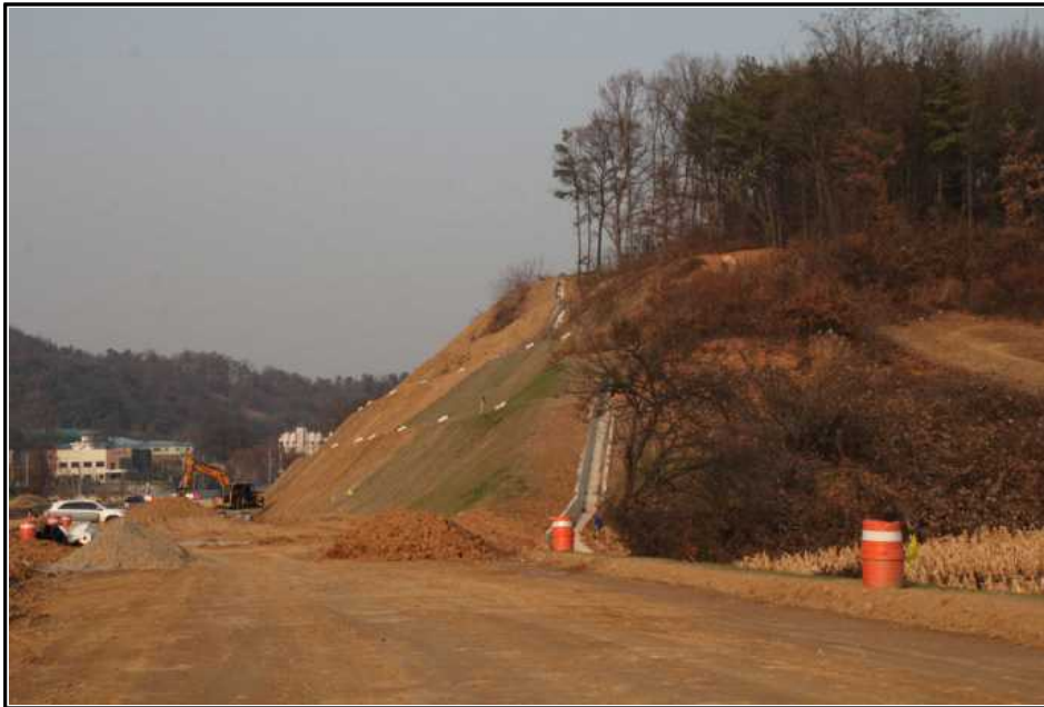
【그림 3】 깎기비탈면 시점부 측면 사진
