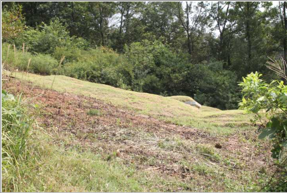
【그림 7】 상부 봉분 (STA,7+160 부근)
