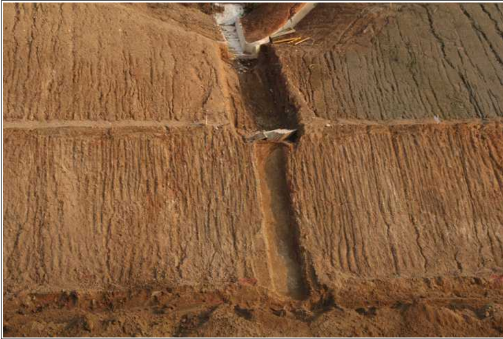
【그림 9】 계곡부 종배수구 설치구간 (STA.7+210 부근)
