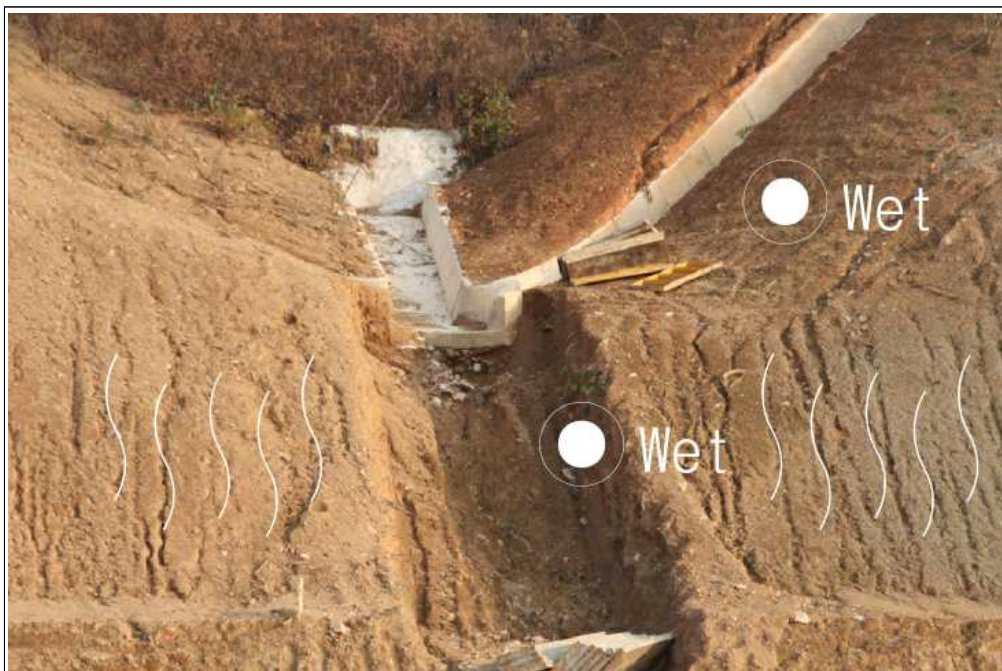
【그림 26】 B 영역 상세사진 (계곡부 형성 및 지하수 유출)
