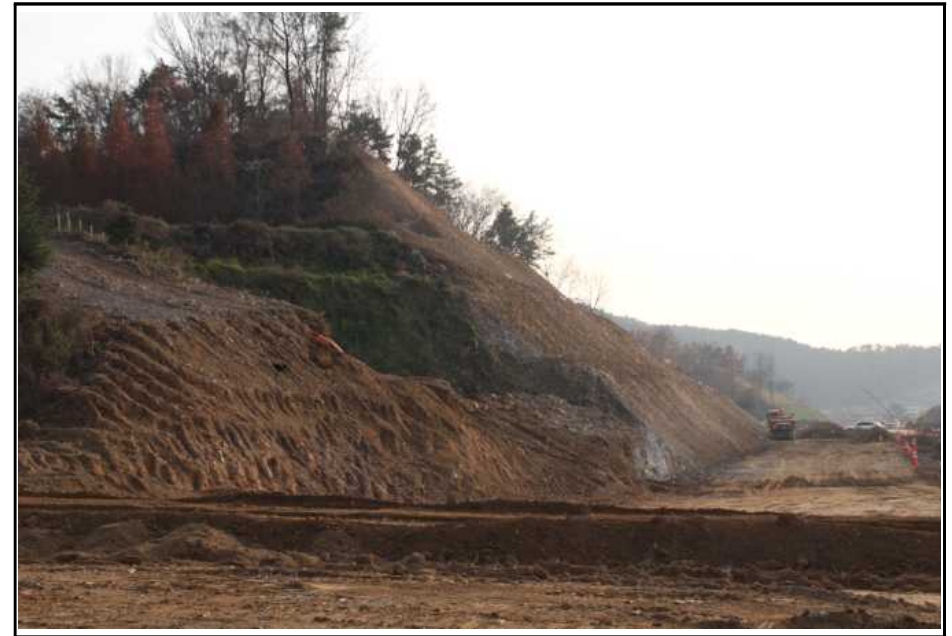
【그림 4】 깎기비탈면 종점부 측면 사진
