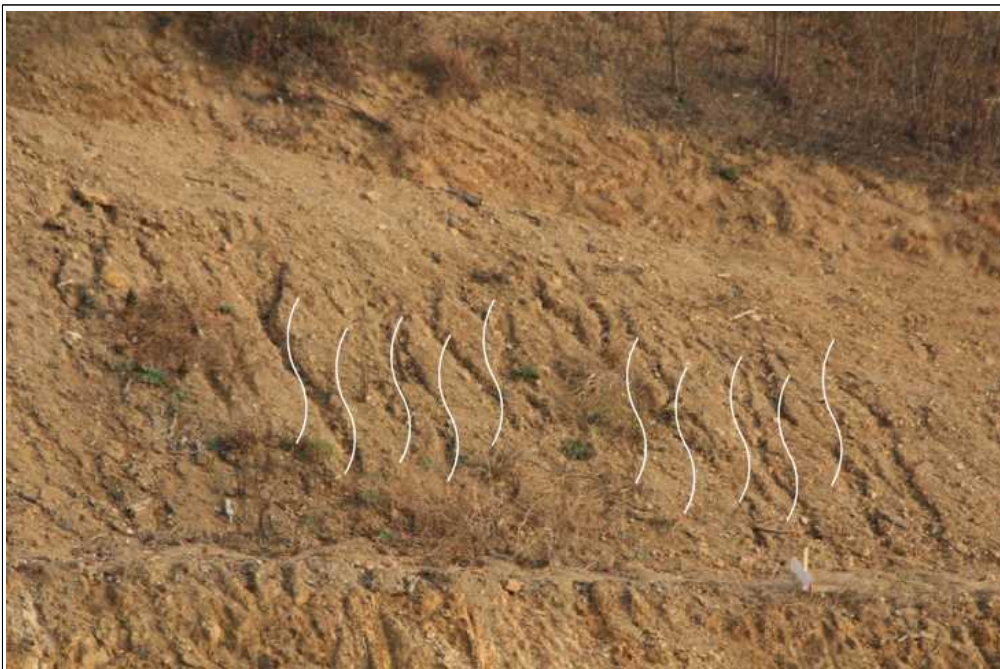
【그림 24】 B 영역 상세사진 (토사유실 및 우류침식)
