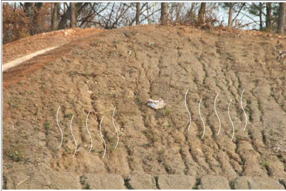
【그림 28】 C 영역 상세사진 (토사유실 및 우류침식)
