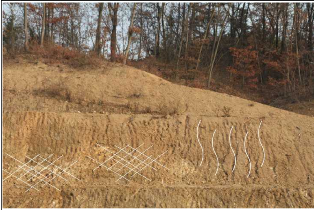
【그림 25】 B 영역 상세사진 (세편화된 암석 및 토사유실)
